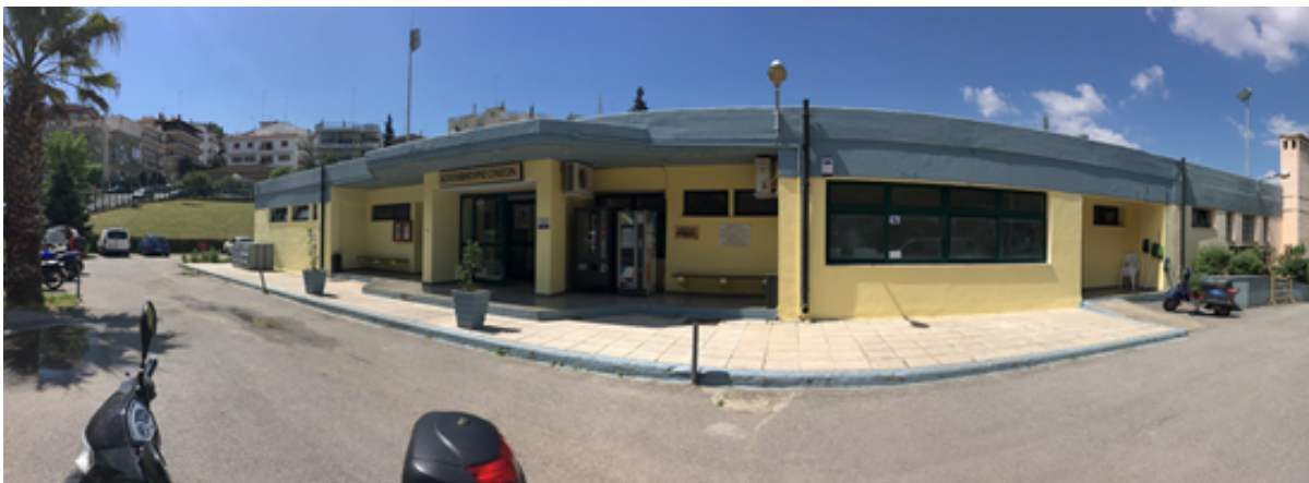
Φωτογραφία 2: Πρόσοψη κολυμβητηρίου
